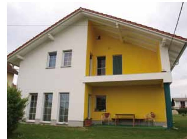
Objekt: obiteljska kuća Zagreb Materijal: Jubizol premium Vrijeme izvođenja: svibanj 2011.
