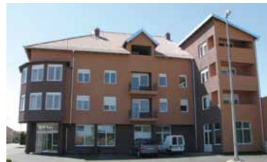
Objekt: stambeno poslovna zgrad Vukovar Materijal: ATG 2.0 1190 i 2171 Vrijeme izvođenja: lipanj 2011.
