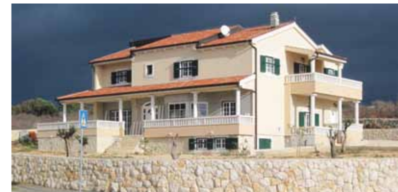
Objekt: Stambeni objekt Novalja, Materijal: SNG 2.0 1124 i 1123 Vrijeme izvođenja: travanj 2011.
