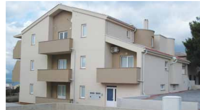
Apartmani Novalja, Materijal: ATG 2.0 1094 i 1122 Vrijeme izvođenja: veljača 2011.
