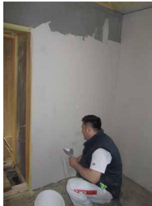
Obrada površina s masom za izravnavanje JUBOGLET.
