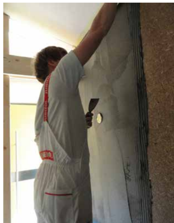
Obrada površina s JUBIZOL lepljivom maltom.
